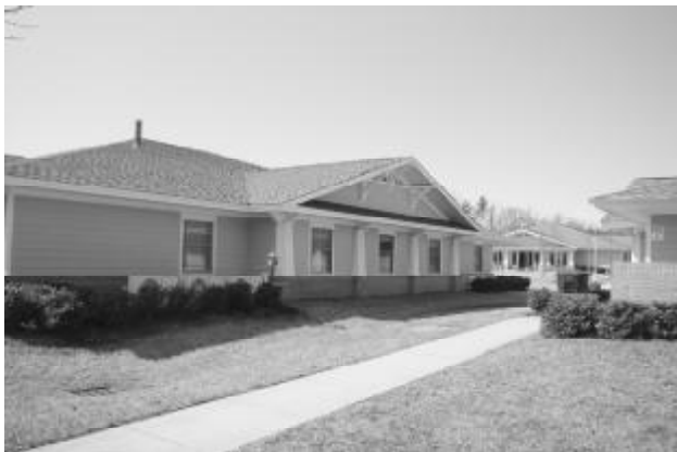
Загальний вигляд будинків Центру для людей похилого віку
